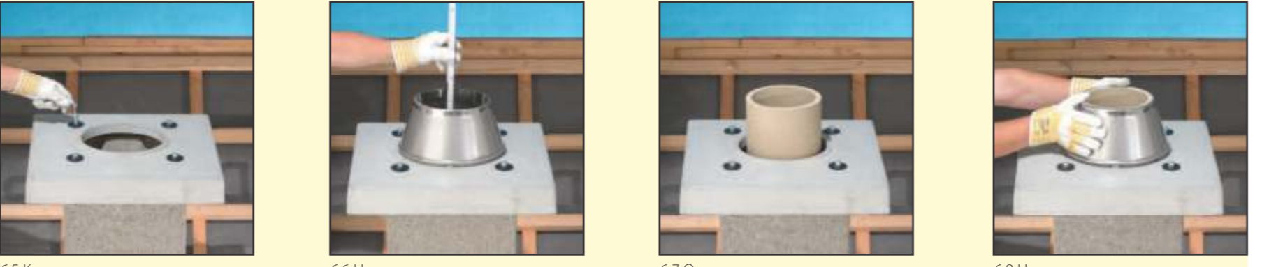
6.5 Крепко прикрутите плиту. 6.6 Наденьте конус и отмерьте недостающую длину трубы. 6.7 Отрежьте недостающую часть шамотной трубы и прикрепите к клею. 6.8 Наденьте конус.
