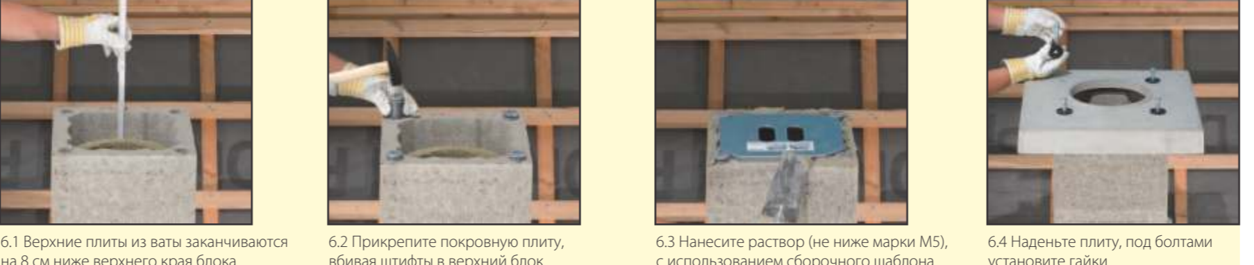
6.1 Верхние плиты из ваты заканчиваются на 8 см ниже верхнего края блока. 6.2 Прикрепите покровную плиту, вбивая штифты в верхний блок. 6.3 Нанесите раствор (не ниже марки М5), с использованием сборочного шаблона. 6.4 Наденьте плиту, под болтами установите гайки.
